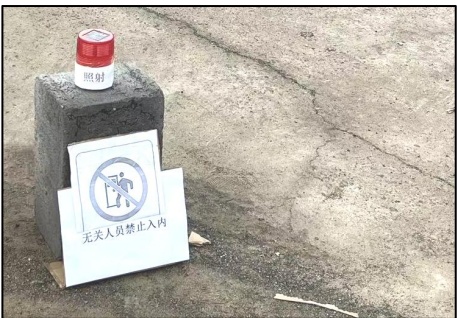
图 3-8 “无关人员禁止入内”警告牌
